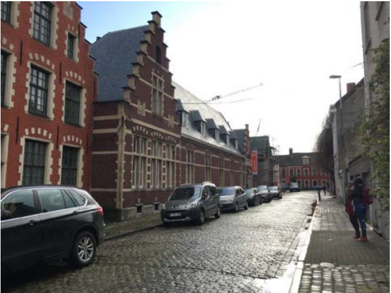
AFBEELDING 51: SCHOOLGEBOUW HIPPO'S HOF
